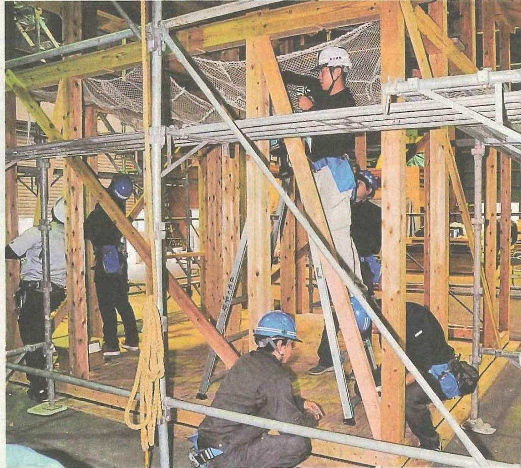
1級建築大工技能士の指導を受けながら柱やはり、桁を設置するなどしてモデル棟を組み上げた。
